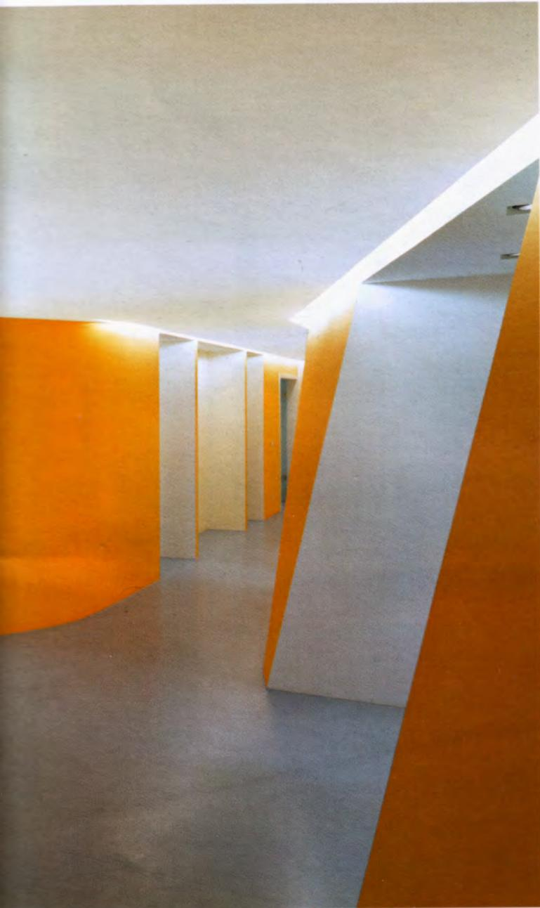
mit einer 12,5-mm-Platte gearbeitet. In Bereichen, in denen die Radien kleiner waren, wurde eine 6,5 mm Formplatte eingesetzt. Trotzdem mussten die großen
